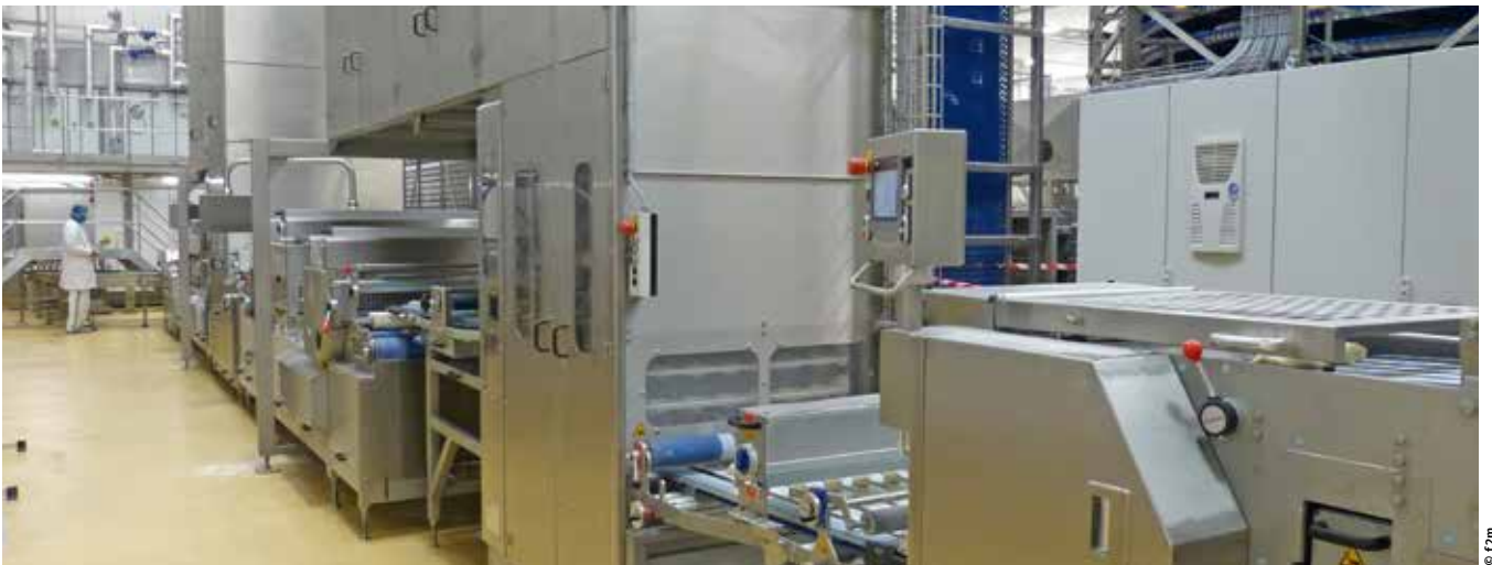
++ Mehrere König-Anlagen, darunter z. B. ein Industrie Rex AW mit Gärschrankanlage KGN für Sandwichbrötchen, haben in der neuen Produktionshalle Platz
